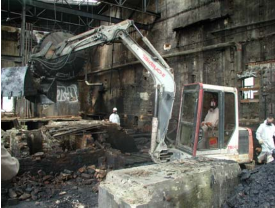
Abbildung 3: Rückbau der Tränkhalle.
